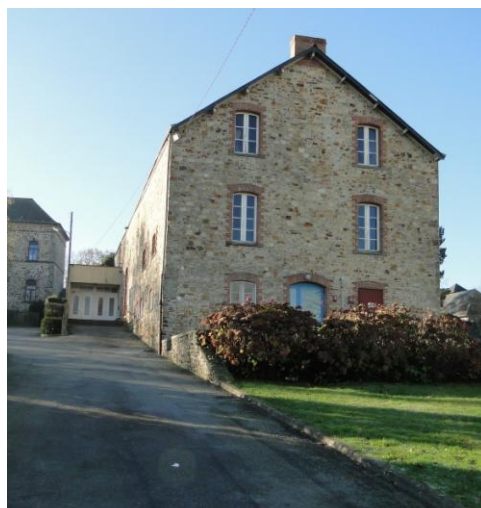
Accès à la salle Sévigné en 2016
