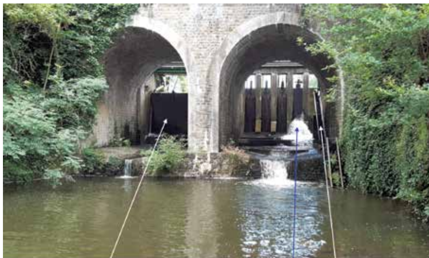
Vue aval du clapet, des 4 vannes, rejet d'eau via l'orifice noyé, passe à anguille
